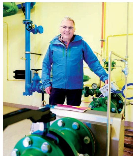
Eine Regel- und Messanlage der Gasversorgung.
